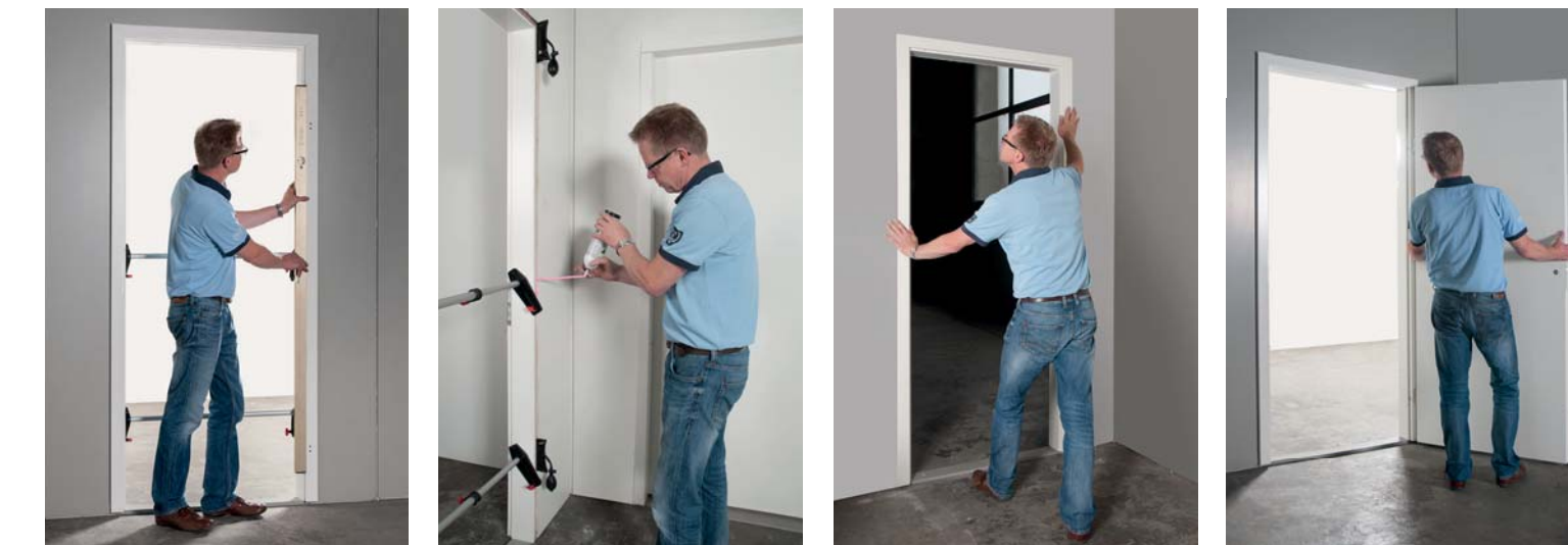
5. Contrôle de l'aplomb.
