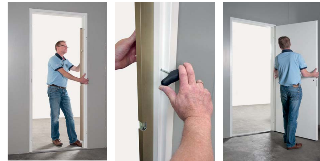
4. Contrôle de l'aplomb.
