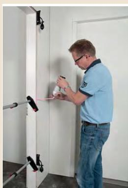
6 • Fixer le chambranle avec de la mousse PU.
