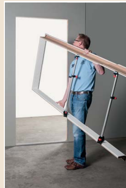
3 • Mise en place des barres d'écartement.
