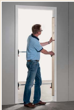
5 • Contrôle de l'aplomb.
