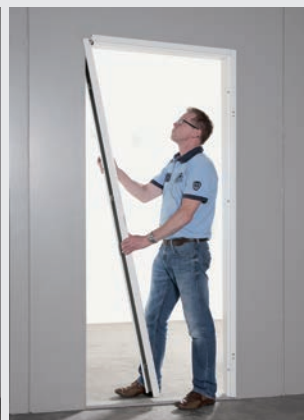
3 • Poser le poteau côté serrure et clipser la traverse.
