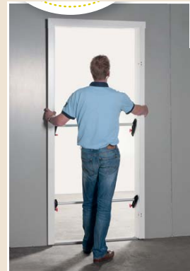
4 • Poser le chambranle dans la réservation.
