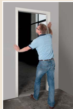
7 • Coller et poser le contre chambranle.
