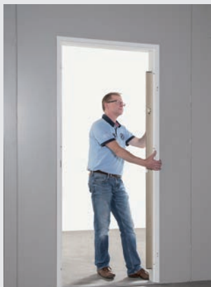
4 • Contrôle de l'aplomb.
