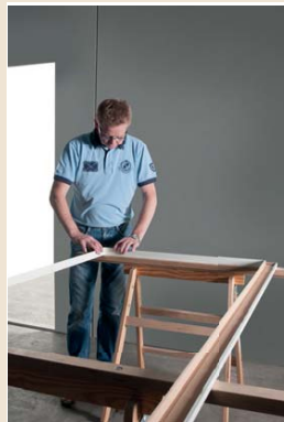
2 • Assembler le contre chambranle.
