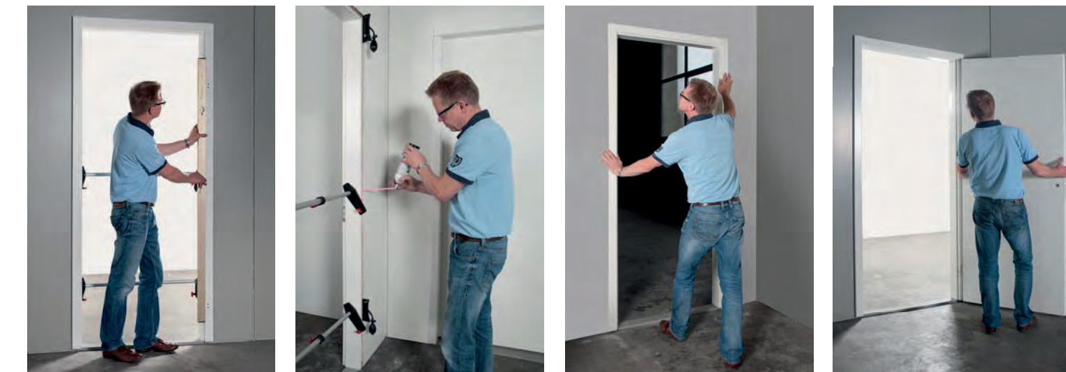
5. Contrôle de l'aplomb.
