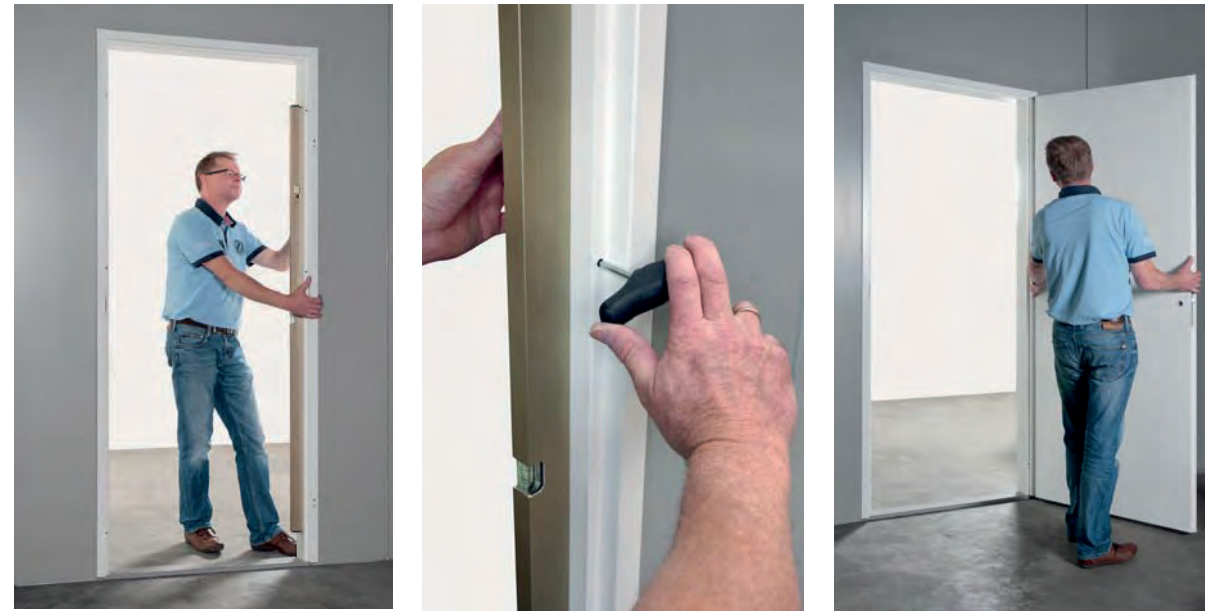
4. Contrôle de l'aplomb.
