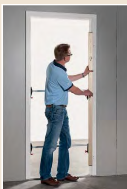
5 • Contrôle de l'aplomb.
