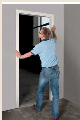
7 • Coller et poser le contre chambranle.
