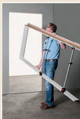
3 • Mise en place des barres d'écartement.
