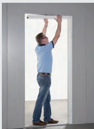
2 • Insérer la traverse dans le poteau côté fiches.
