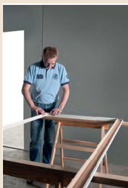
2 • Assembler le contre chambranle.
