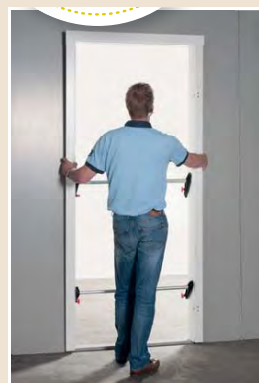
4 • Poser le chambranle dans la réservation.
