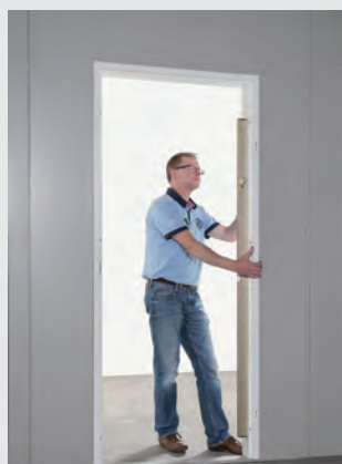
4 • Contrôle de l'aplomb.
