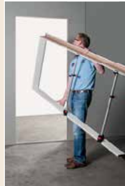
3 • Mise en place des barres d'écartement.
