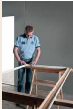
2 • Assembler le contre chambranle.
