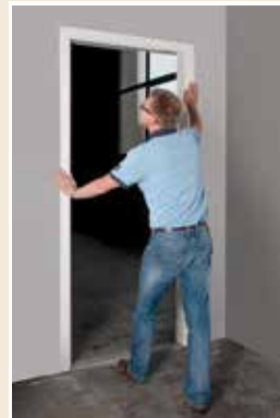
7 • Coller et poser le contre chambranle.
