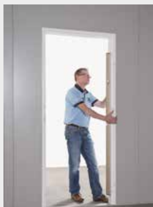
4 • Contrôle de l'aplomb.
