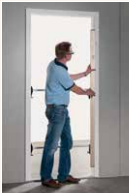
5 • Contrôle de l'aplomb.
