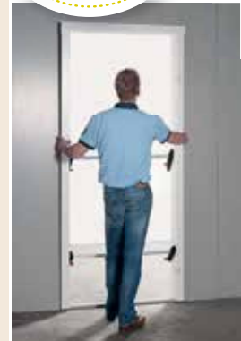
4 • Poser le chambranle dans la réservation.
